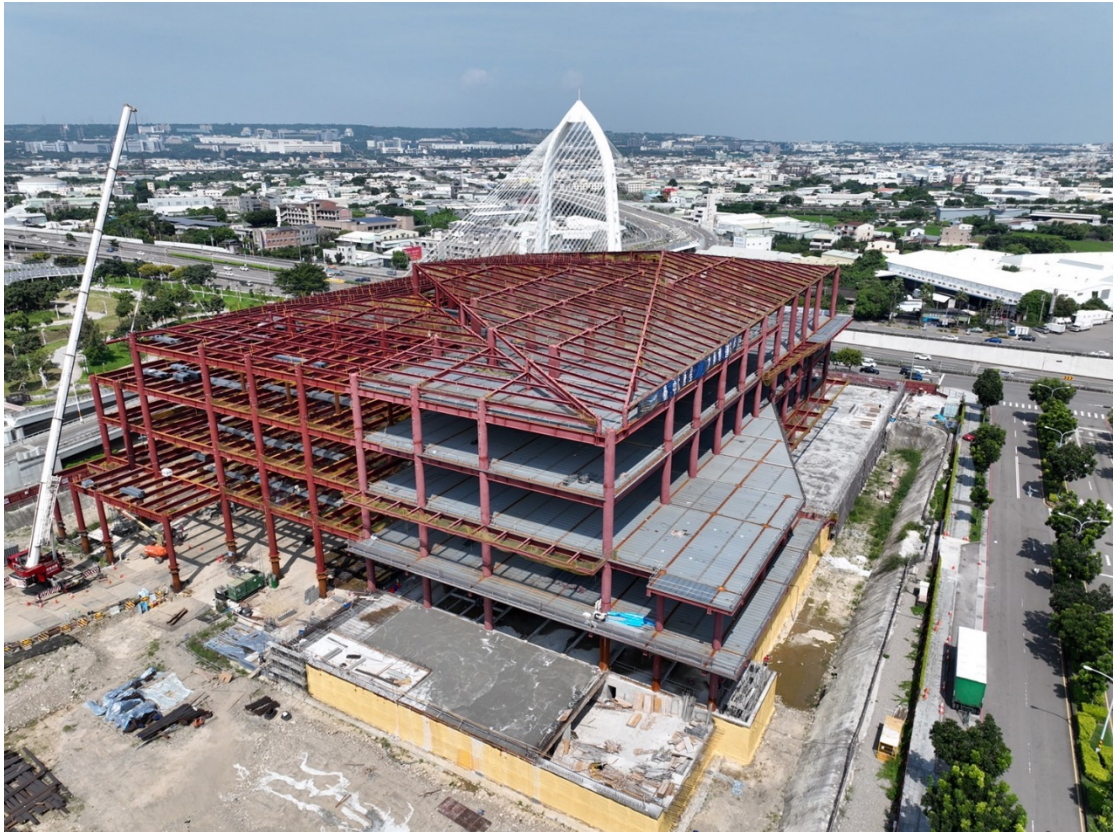
圖 1 水滸轉運中心現況施工照片
