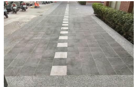
■鋪面破損改善後
