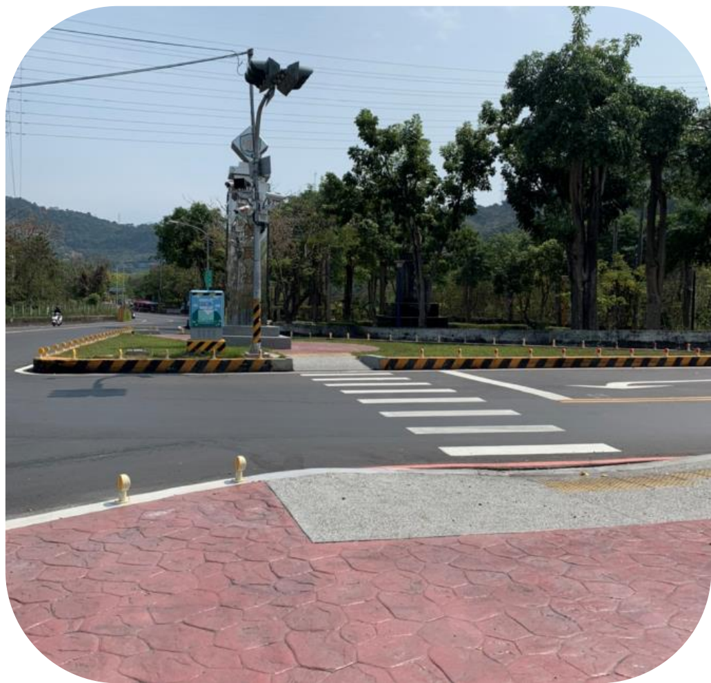
大里區銀聯一橋西側-庇護島
