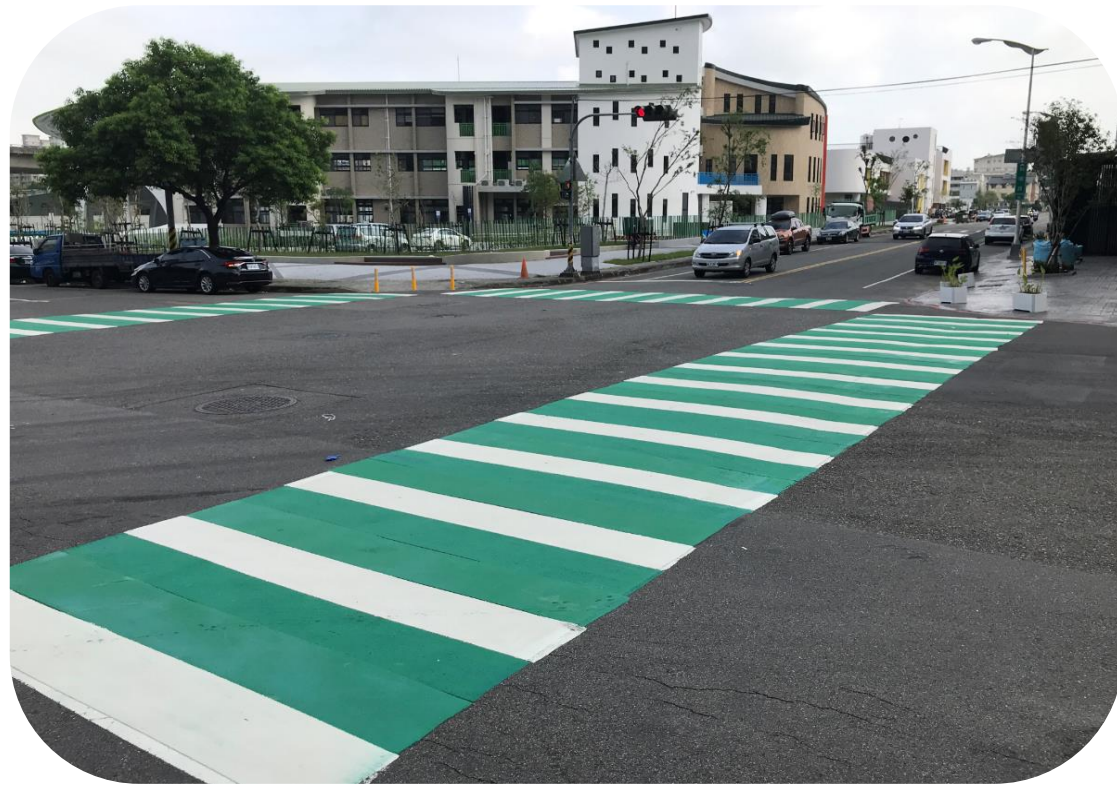
北屯區廓子國小(和順路與景賢路)
