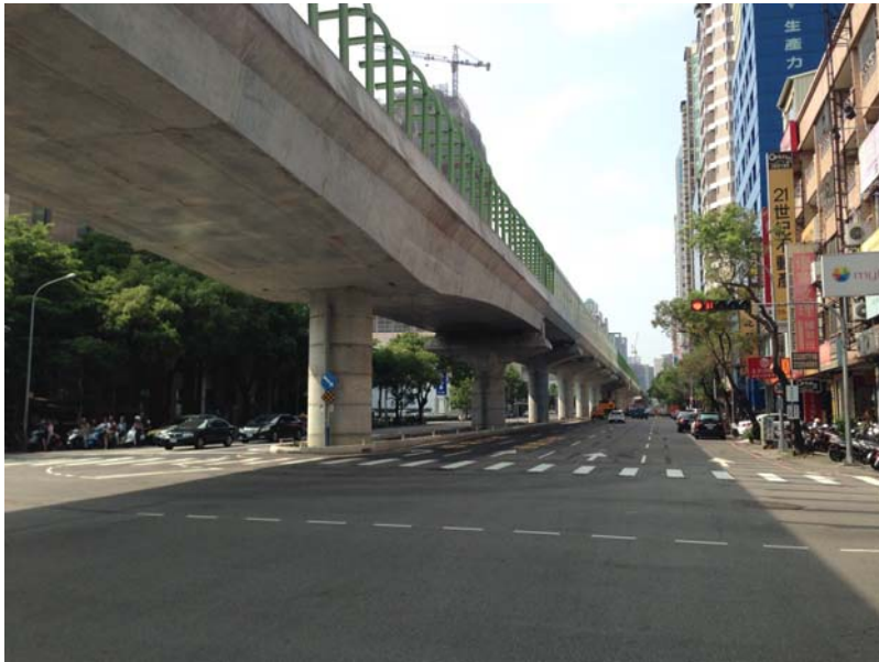
圖 12 捷運沿線施工圍籬拆除現況
