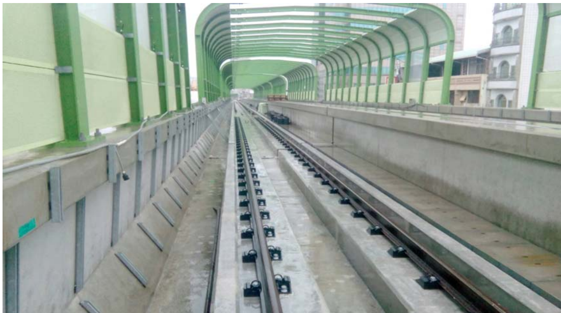
圖 8 路線段軌道完成現況
