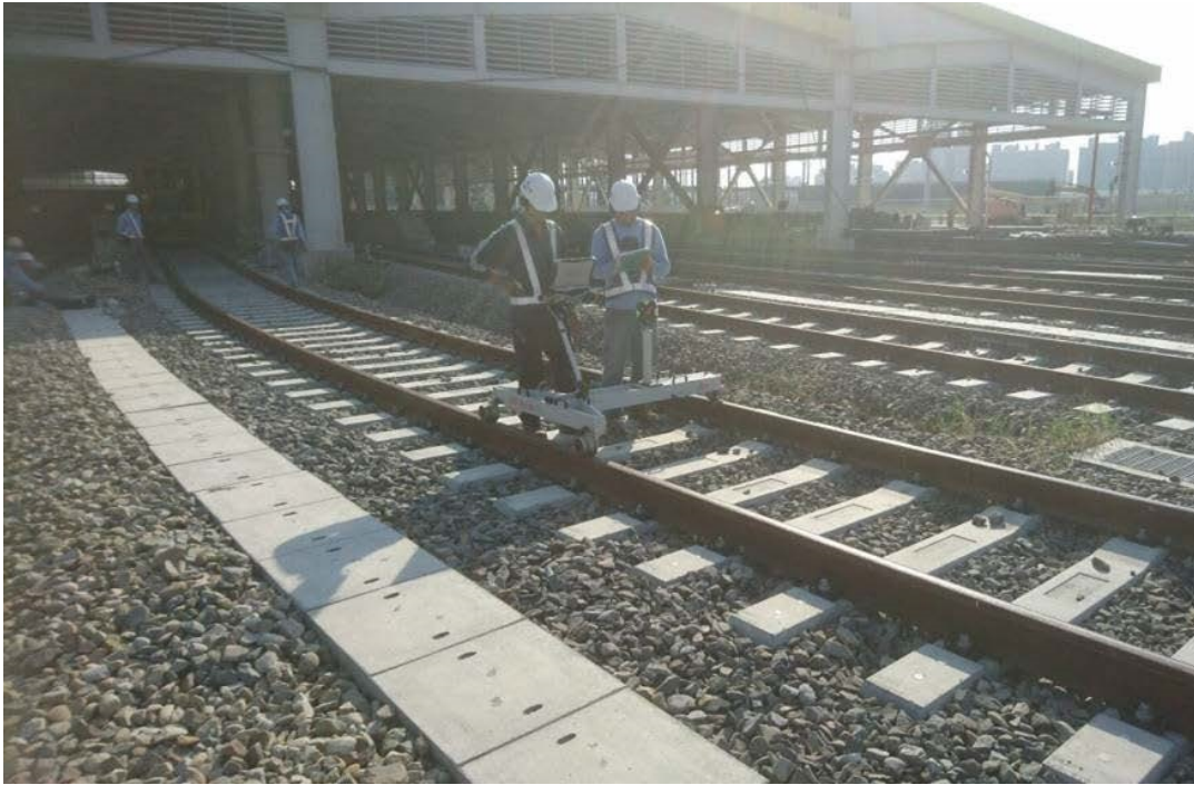
圖 7 北屯機場軌道施作現況
