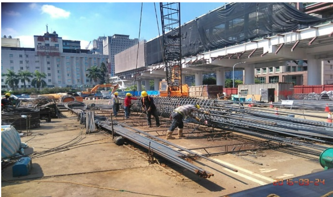
圖 5 共構工程施工現況
