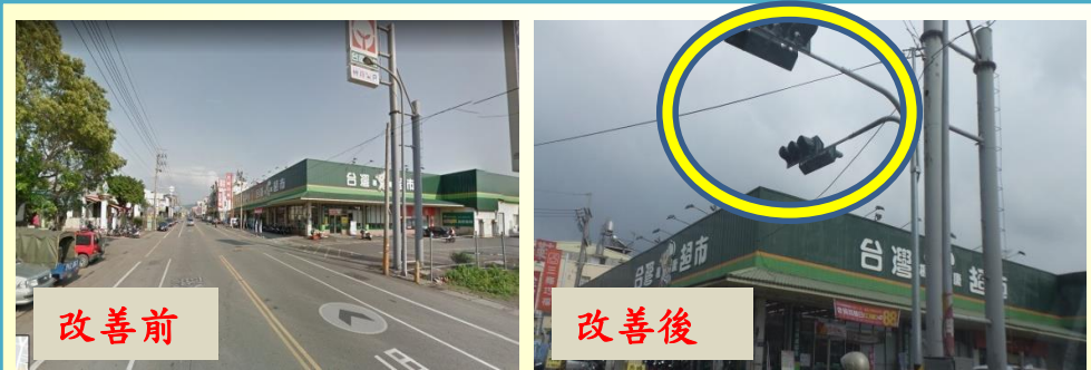
后里區甲后路一段958號增設三色號誌
