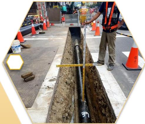
管溝開挖寬度、深度查驗
