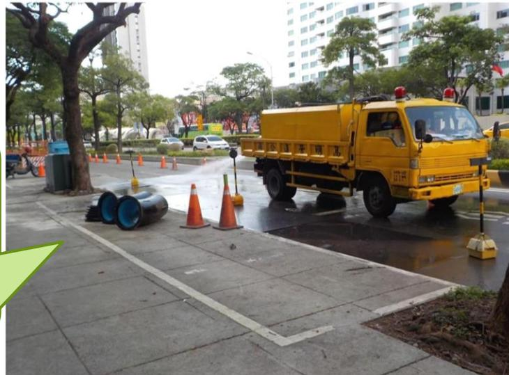
✓ 依規放置施工告示牌並設置電動旗手、義交指揮交通
