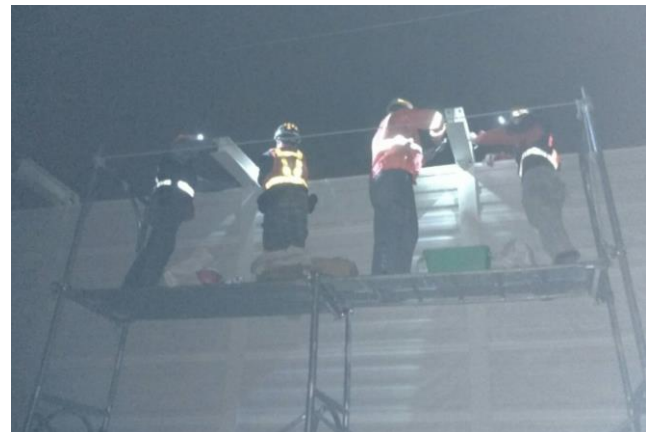
4. 安裝頂部橫梁及金屬吸音板
