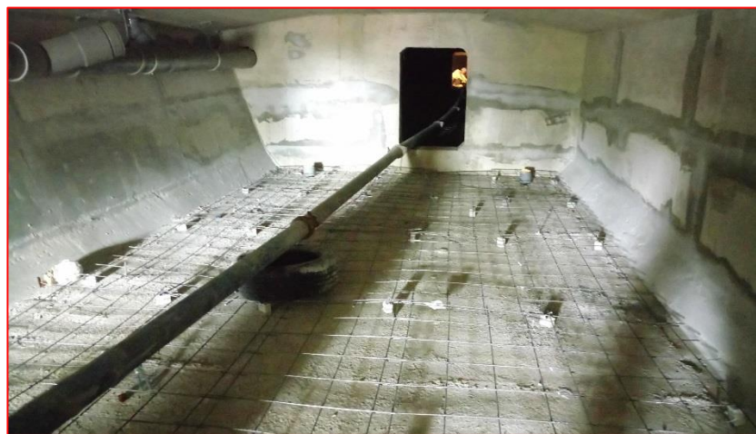
2. 鋪設點焊鋼絲網
