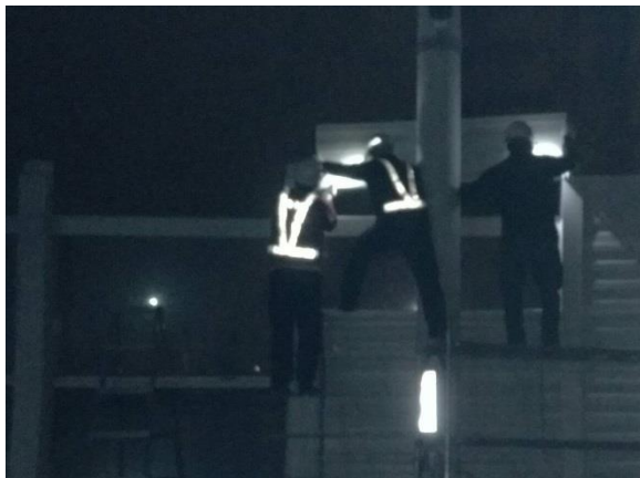
3. 安裝金屬吸音板
